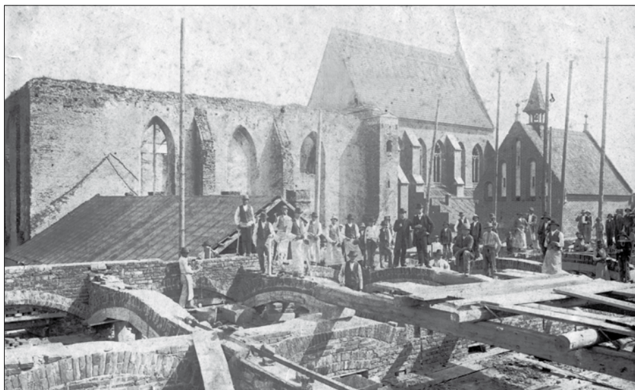
Początki odbudowy – w tle widoczna odrestaurowana kaplica św. Jacka i prezbiterium dawnego kościoła św. Krzyża.
