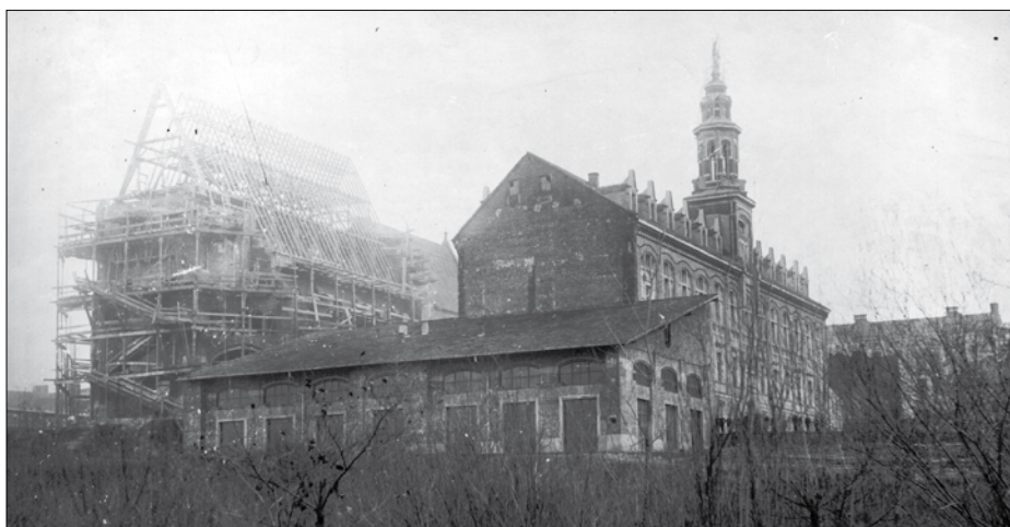
Odbudowa nawy głównej kościoła.
